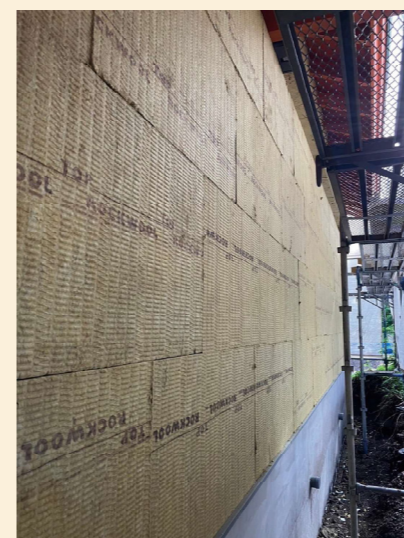
▲外壁のロックウォール施工 断熱材間の大きな隙間が無いが、設計図通りの厚み通り施工されているかなどを確認
