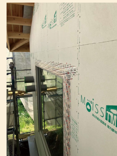
▲窓廻りの気密施工 窓廻りからの気密漏れの無いよう、気密テープ等でしっかり施工されているかを確認
